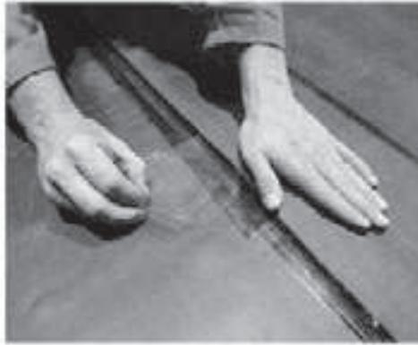
Rouler le joint avec le rouleau silicone ergonomique de 4 cm de large.
